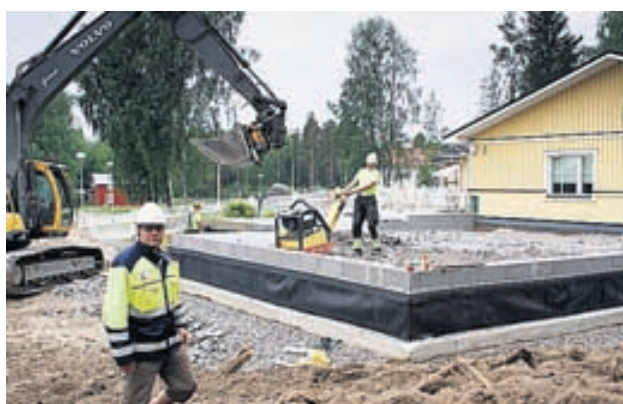
Fastighetschefen Johan Strand inspekterar dagistillbyggnaden i Maxmo. Inne i sockeln, med vit hjälm, står arbetsledaren Emil Svens.
